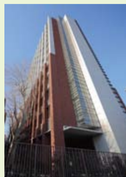
▲マキムホール (15号館)
