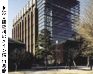
▲独立研究科のメイン棟 11号館
