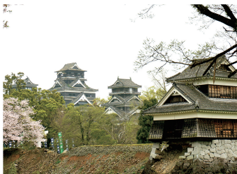
震災後、復旧を待つ熊本城
